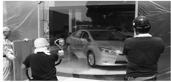
「フミンコーティング」の施工風景
