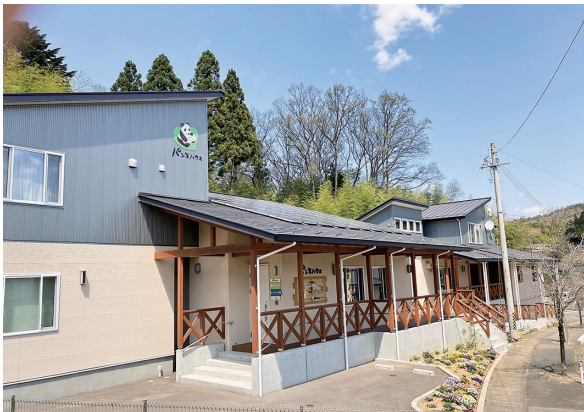
パンダハウスの外観
